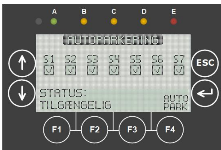
Figur 4. Siden for autoparkering af kranen.
